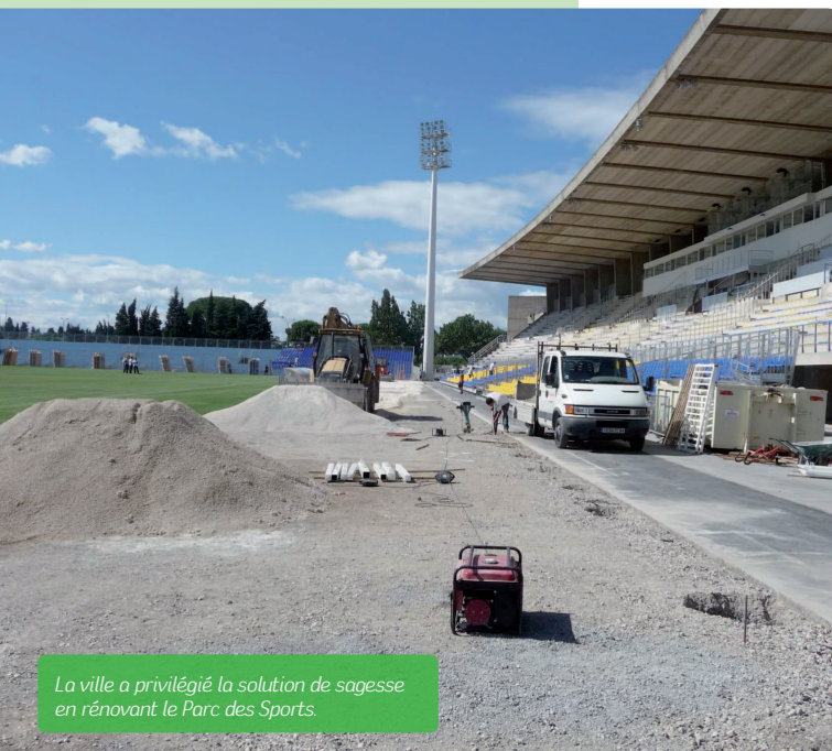
L'objectif des premiers travaux était de refaire la planimétrie du terrain avec l'apport de matériaux et du gazon de placage.
